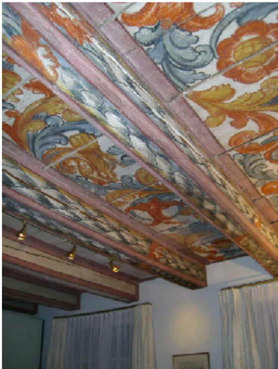
Malereien auf Tragbalken. Münsterberg 10, 4051 Basel
