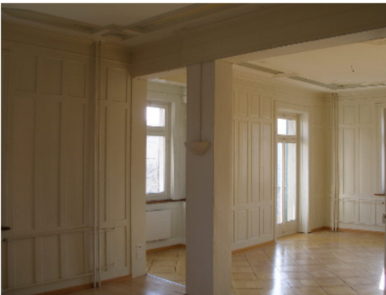
Getäfelte Wände. Hagenstr. 51, 9014 St. Gallen
